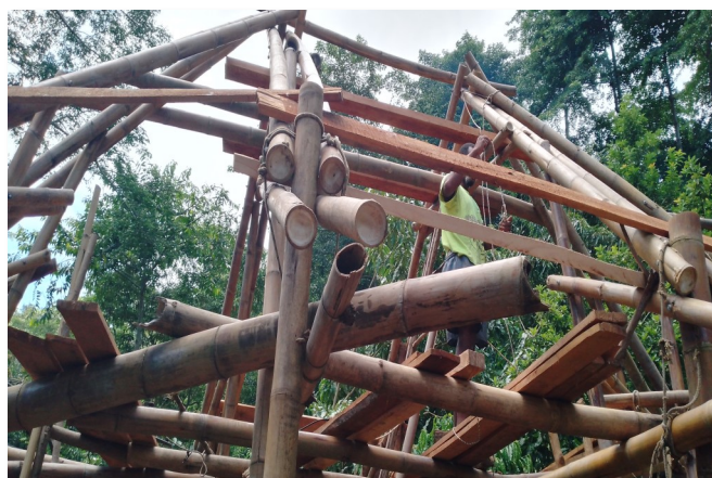
Charpente en bambou
