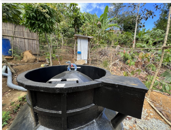
Digesteur biogaz
